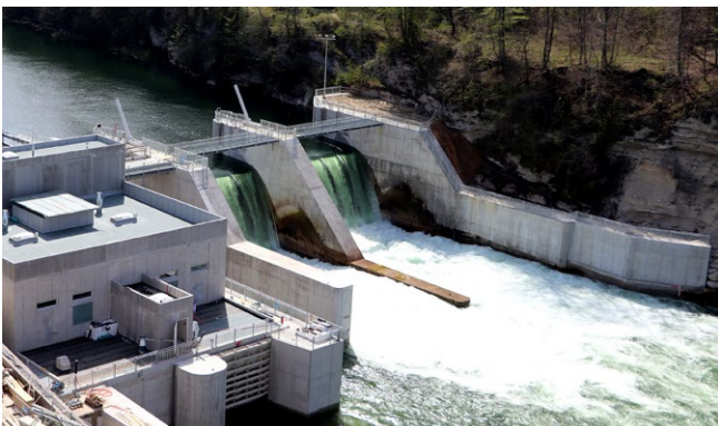
Frühzeitige Schadenserkennung bei Flusskraftwerken
